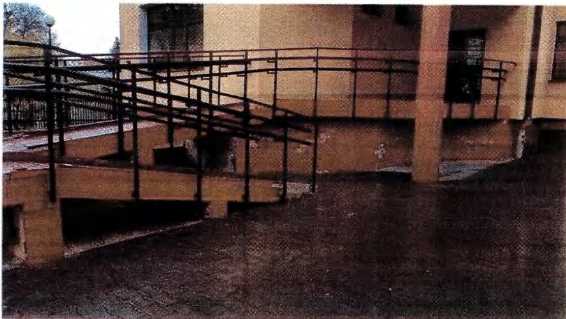
Foto 2. Widok podjazdu od południa
