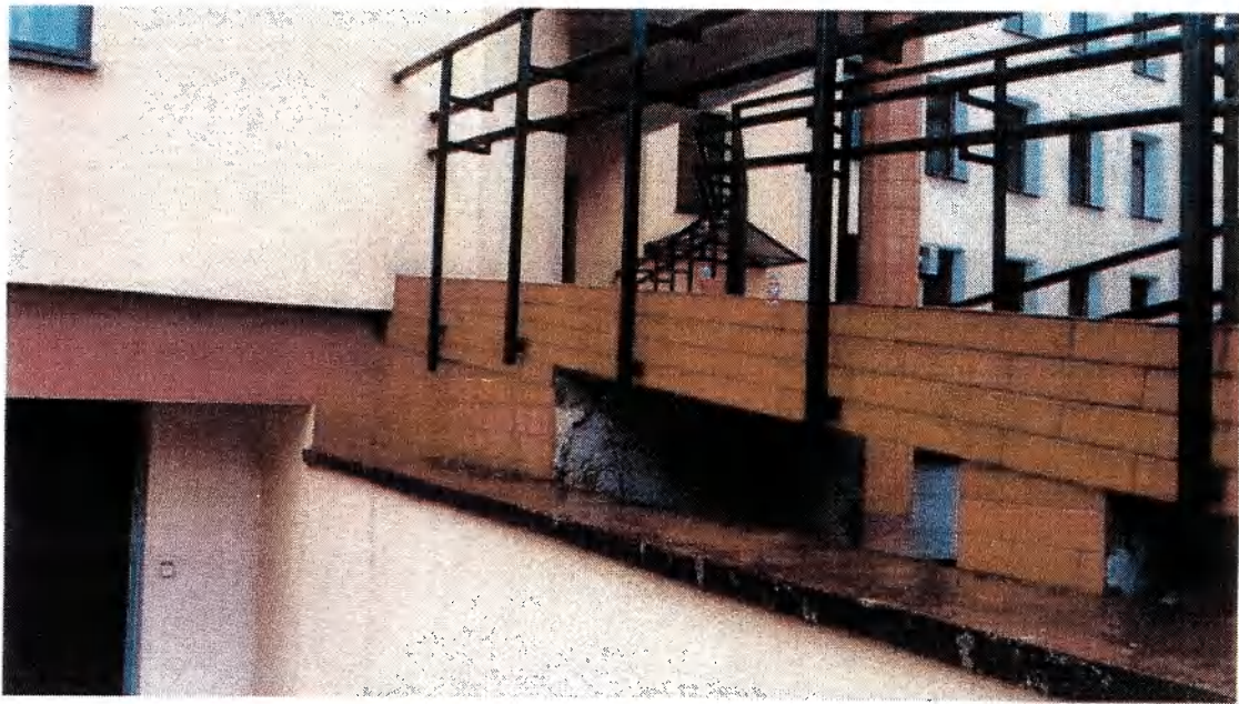
Foto 4. Widok podjazdu od północy
