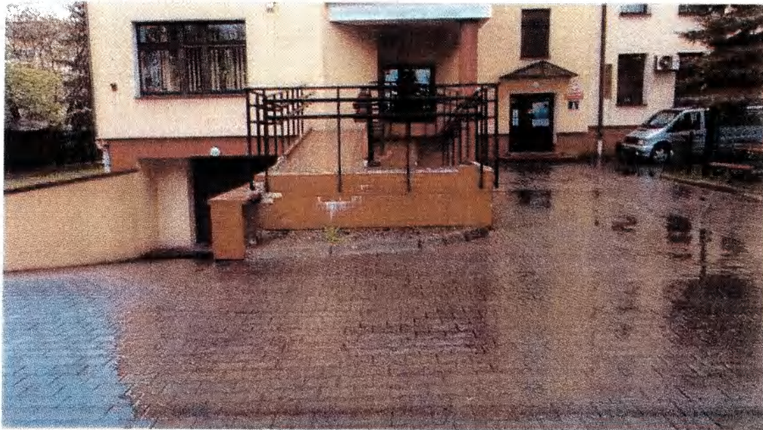
Foto 1. Widok podjazdu od zachodu
